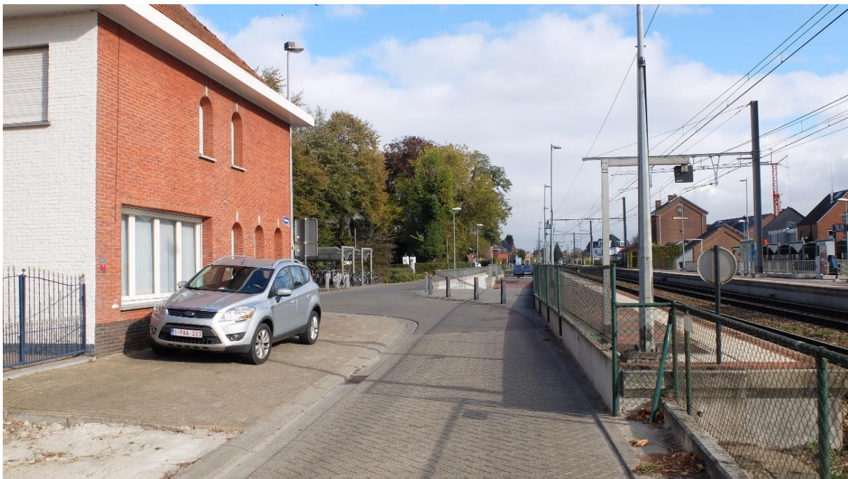
FIG 133 Spoorwegstraat in noordoostelijke richting – naderen kruising Station Tienen (ten oosten) en De Willaert (ten westen)
