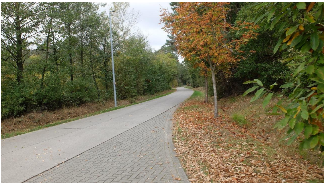
FIG 153 Kruispunt Tieleneide x Zwepenstraat in noordelijke richting – overgang klinkers naar beton
