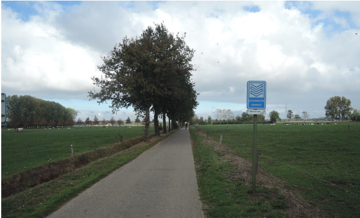
FIG 118 Cawinkel ten noorden van de spoorwegovergang, in noordwestelijke richting – begin beschermingszone drinkwater
