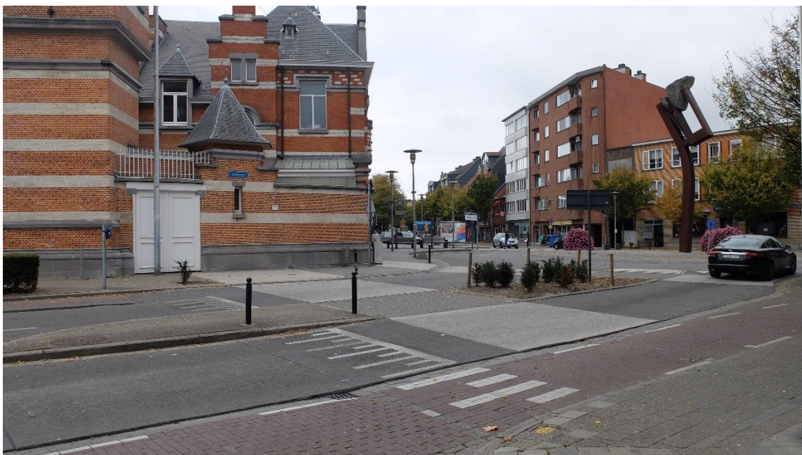
FIG 202 Station Turnhout in noordoostelijke richting – oversteekplaats (niet conform en niet bewegwijzerd) voor voetgangers of fietsers
