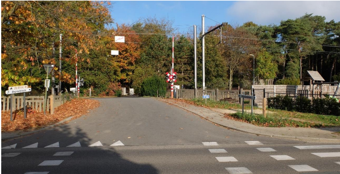
FIG 88 Oversteek Lichtaartseweg (N123) richting Bosbergen in noordwestelijke richting – spoorwegovergang
