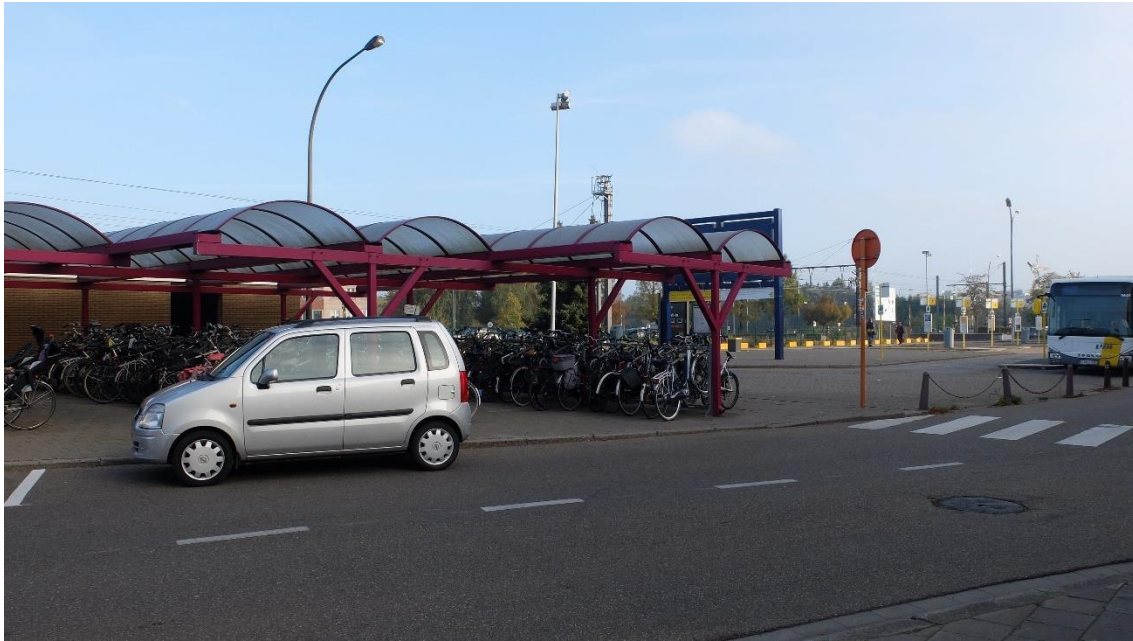
FIG 56 Fietsenstallingen en bushaltes ten noordoosten van het station Herentals
