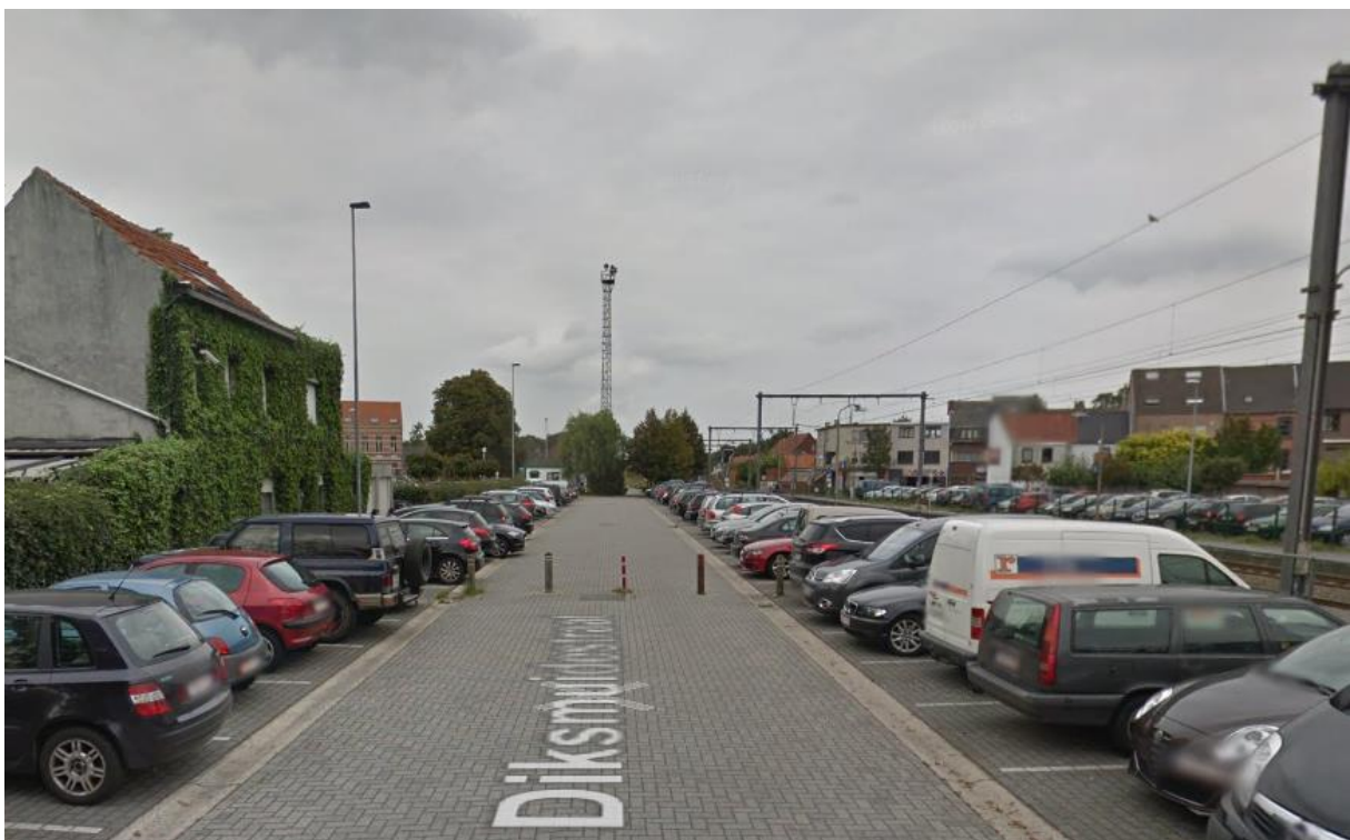
FIG 206 Tweede deel Diksmuidestraat – dwarsparkeren aan weerszijden van de rijweg. Halverwege is de rijweg geknipt d.m.v. paaltjes voor doorgaand autoverkeer, kijkrichting noord (bron: google maps)
