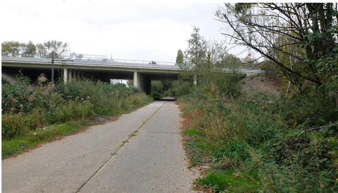
FIG 171 Fietsroute langs spoor x A21 (ongelijkvloerse kruising) in noordelijke richting
