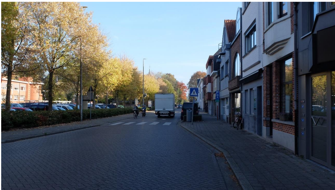
FIG 68 Nederrij (N123) in noordelijke richting – ter hoogte van ingang AZ St. Elisabeth – oversteekplaats voetgangers aangeduid met bord F49
