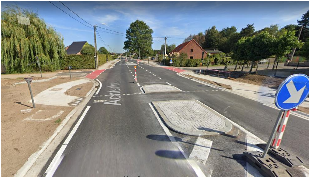
FIG 115 Recent heraangelegde toestand N134 x Cawinkel – kijkrichting oost (bron: google maps)
