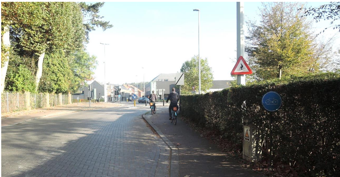
FIG 72 Nederrij (N123) in noordelijke richting – verplicht fietspad aan beide zijden, aangeduid met bord D7 vanaf einde bebouwde kom (naderen ovonde N123)
