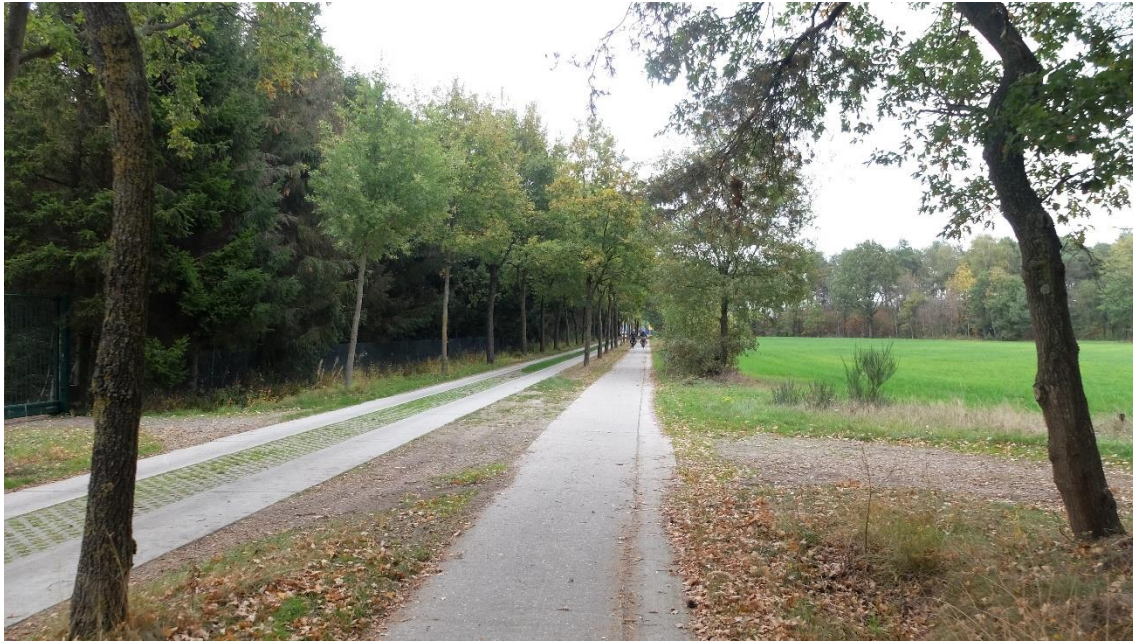
FIG 162 Kraanschot in noordoostelijke richting – meest noordelijke deel van het segment – dubbelrichtingsfietspad aan westelijke zijde van Kraanschot, gescheiden van de rijbaan door een zachte berm met bomen
