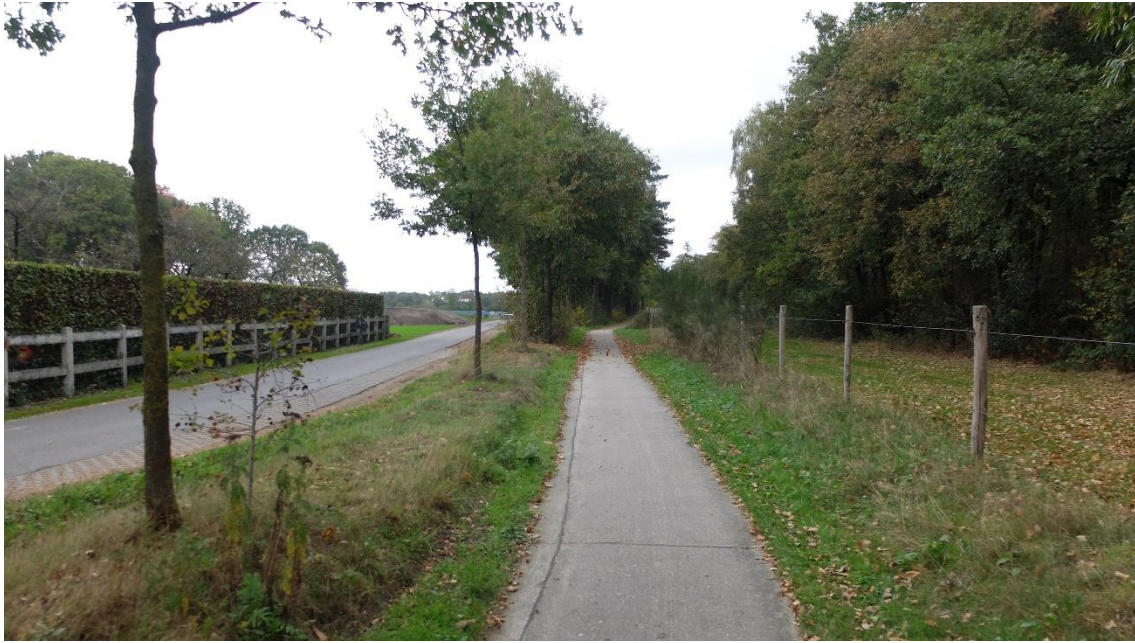
FIG 160 Kraanschot in noordoostelijke richting – dubbelrichtingsfietspad aan oostelijke zijde van de weg, gescheiden van de rijbaan door een zachte berm met bomen
