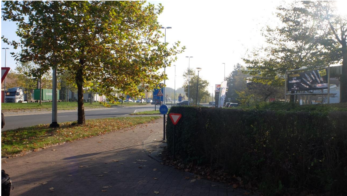
FIG 74 Ovonde in oostelijke richting – dubbelrichtingsfietspad aangeduid met bord D7
