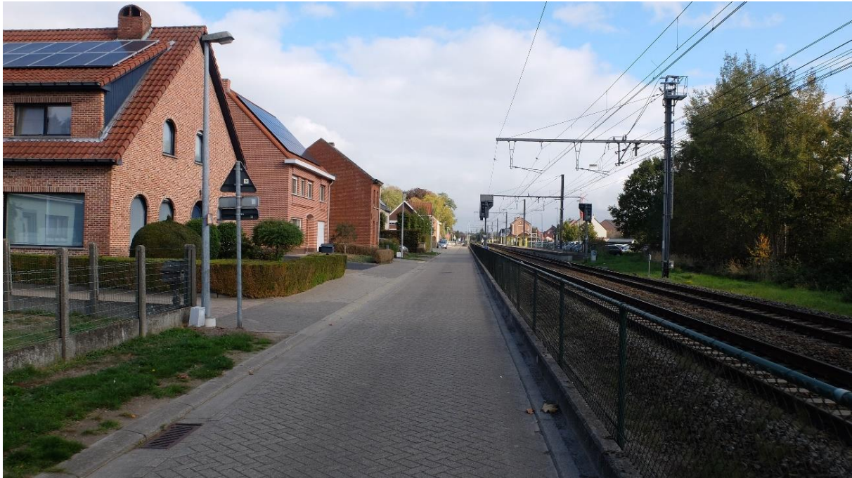
FIG 132 Spoorwegstraat in noordoostelijke richting – afscheiding spoor hier reeds aanwezig
