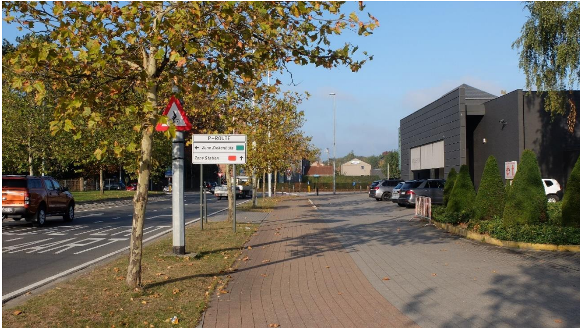
FIG 78 Noordelijke zijde van de ovonde in westelijke richting – dubbelrichtingsfietspad
