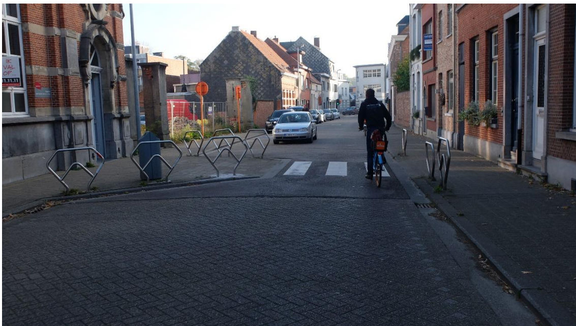
FIG 63 Hikstraat in noordoostelijke richting – wegversmalling en oversteekplaats voetgangers – parkeren langs westelijke zijde rijbaan
