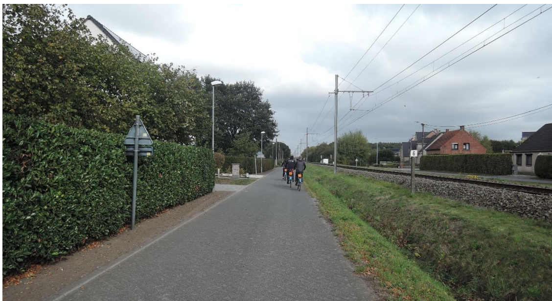
FIG 145 Spoorwegstraat in noordoostelijke richting – gemengd verkeer en klinkers – afscheiding spoorweg ontbreekt hier
