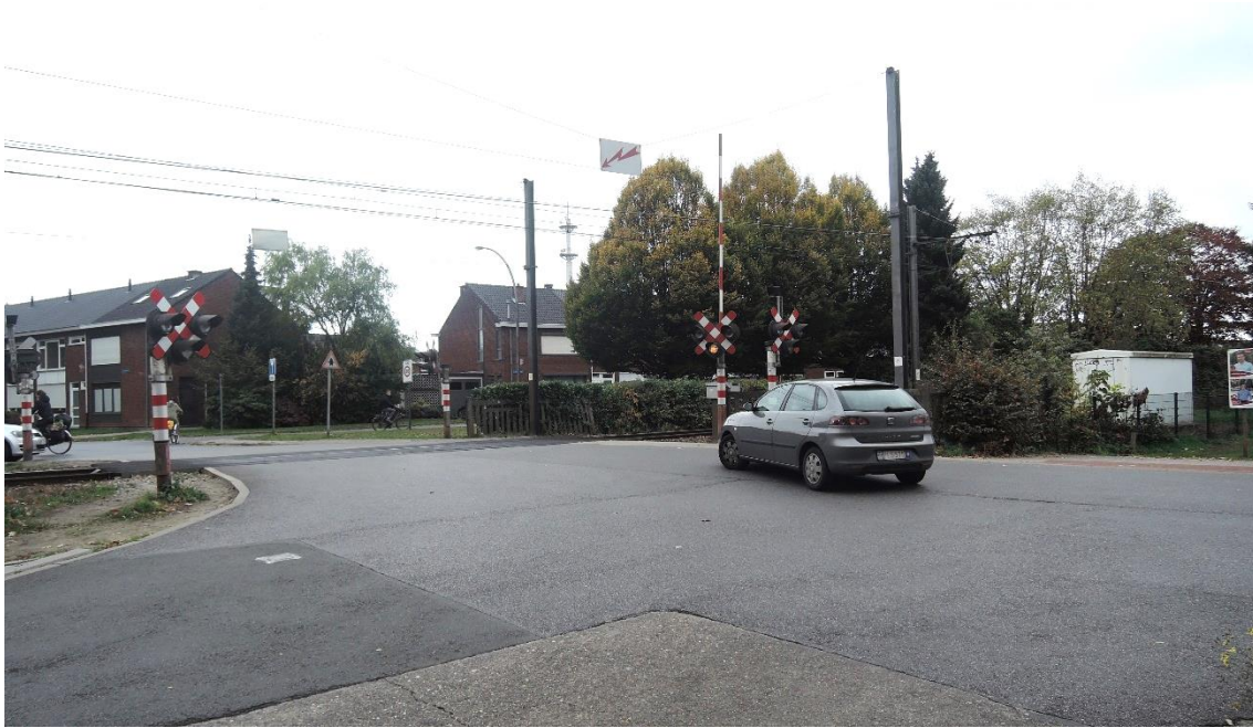
FIG 188 Kruispunt Vuurkruisenstraat in noordwestelijke richting – spoorwegovergang met slagbomen
