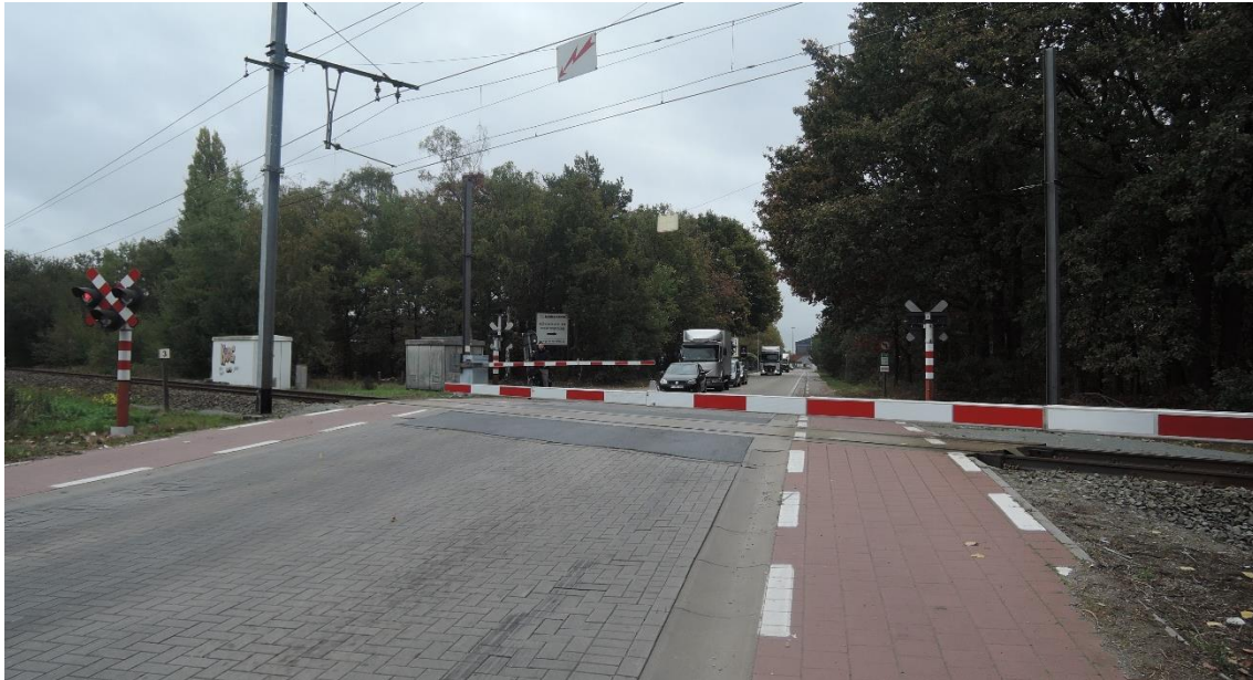
FIG 168 Spoorwegovergang met slagbomen op Veedijk in oostelijke richting
