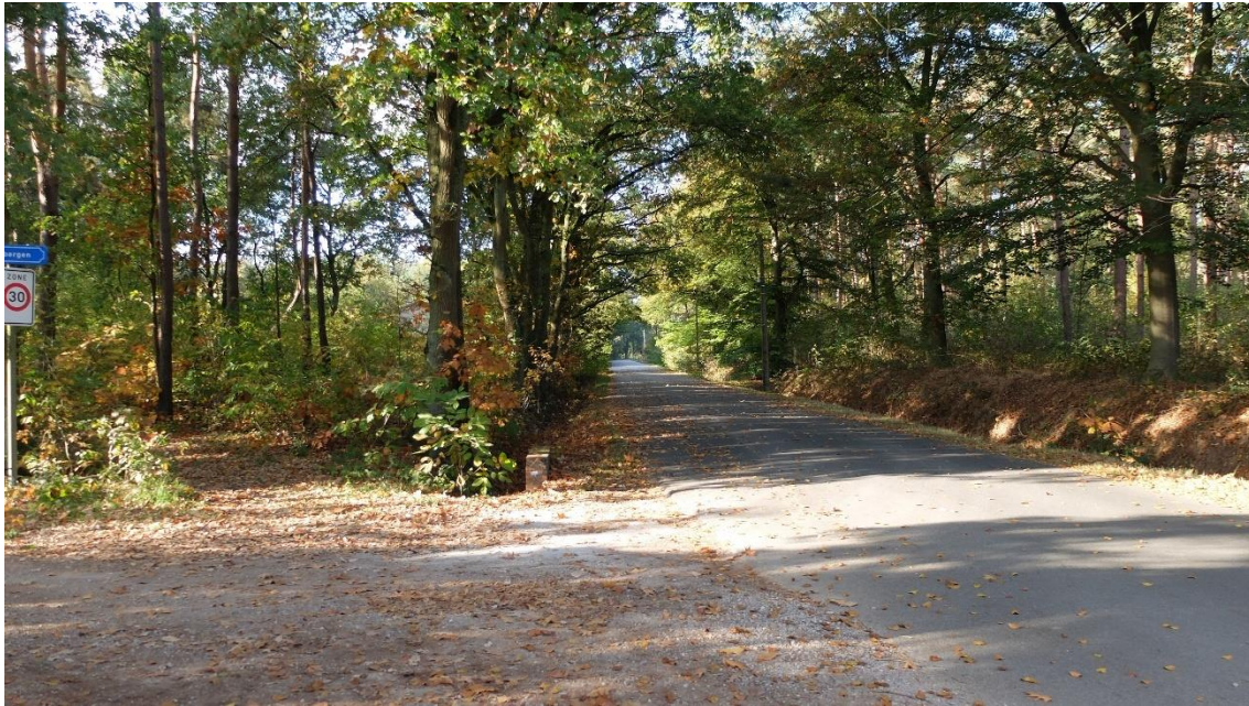
FIG 100 Kruising Bosbergen x Hulzen in westelijke richting - wijziging snelheidsregime (zone 30 naar zone 70)
