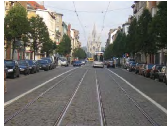
Bielefeld met dubbel tramstel (54 m x 2,30 cm) op geheel vrije baan op meterspoor (links) en Schaarbeek, Koninginnelaan met bijzondere overrijdbare bedding met tramstel (2,30 x 43,3 m) op normaalspoor (1,435 m)
