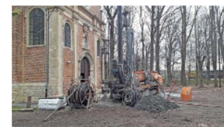
Aan de Boskapel in Imde wordt een warmtepomp geïnstalleerd. © Parochie Wolvertem
