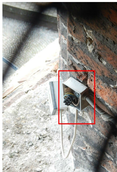
Openstaand verbindingspotje in galmgat.
