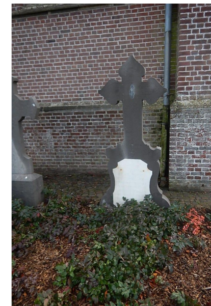
Roestige bevestigingen van het witmarmere opschrift.
