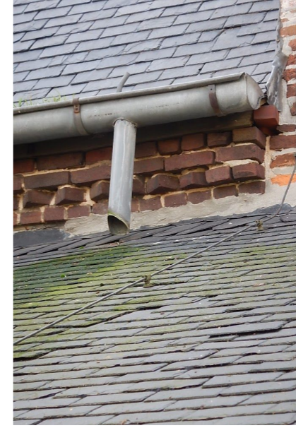
Te verlengen afvoer.
