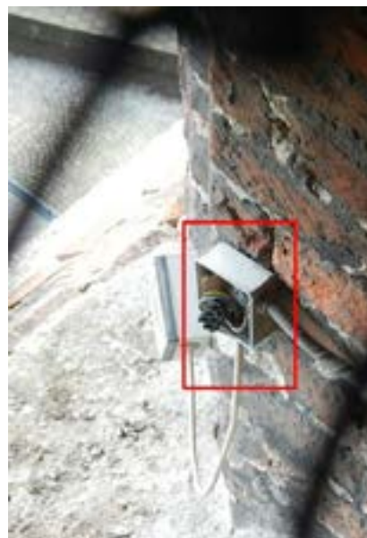
Openstaand verbindingspotje in galmgat.
