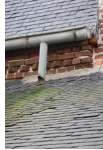
Te verlengen afvoer.
