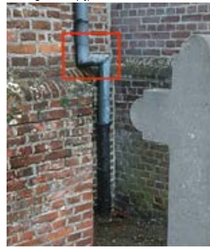
Te vermijden aansluiting.
