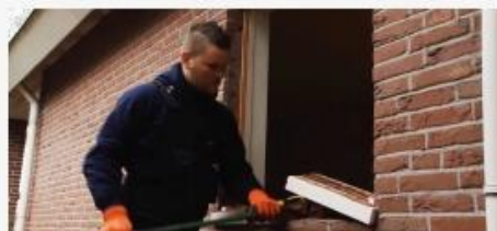
Vervangen buitenschrijnwerk en beglazing
