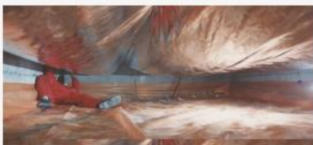
Isoleren vloer / kruipruimte
