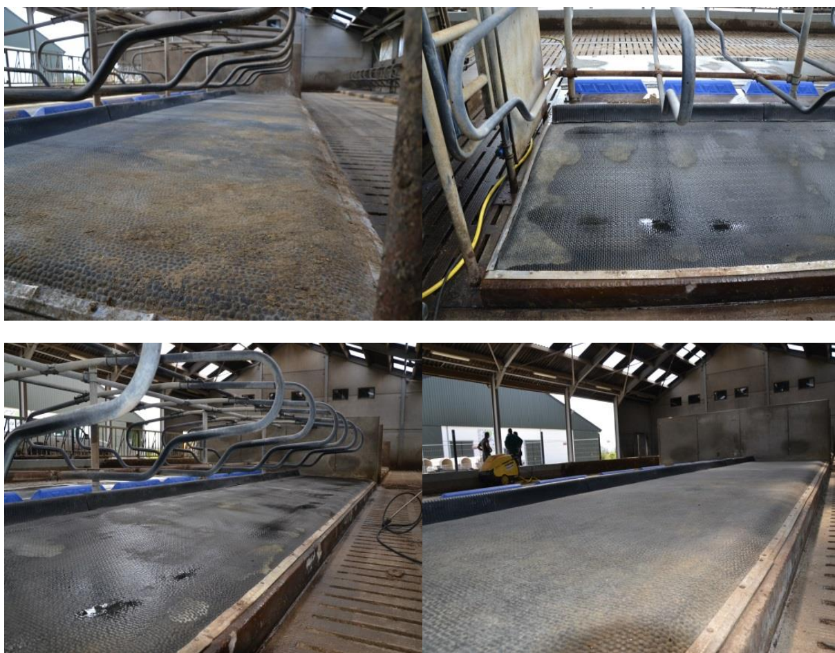
Figuur 10: foto's van Agriprom matras met rubberdek bij de afbraak in 2016 (einde demo)
