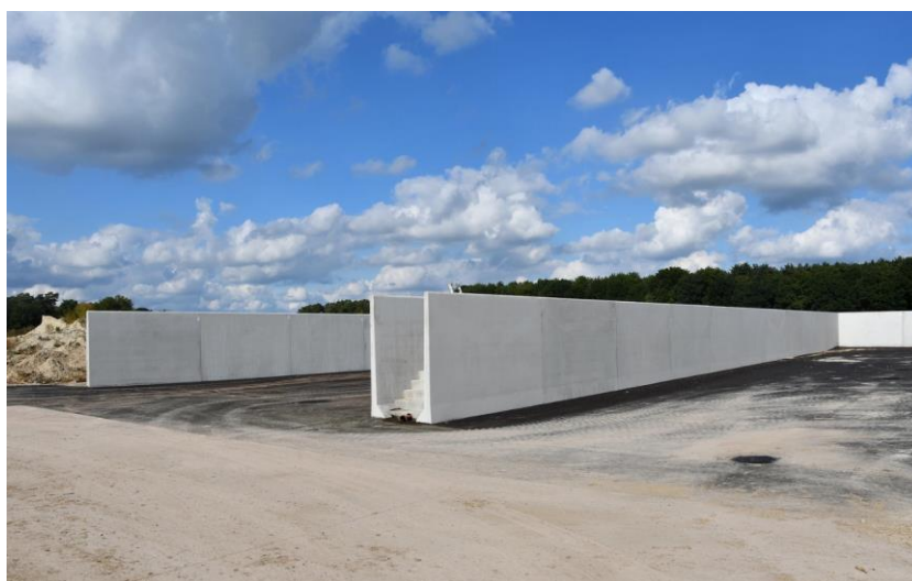
Figuur 8. CBS beton – sleufsilo
