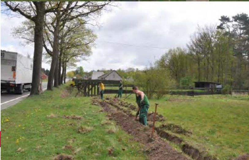
Aanleg buiten-gevoene plekies
