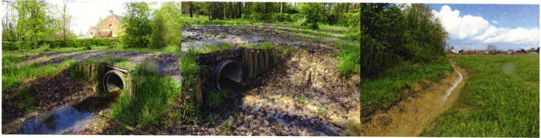
Foto 1-2: Verbinding Molenbeek met bypass door buis (diameter 80cm)
