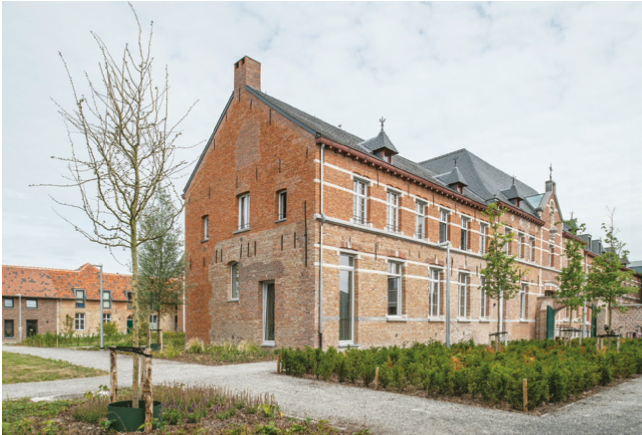
▲ Het gerenoveerde klooster past zich op een vanzelfsprekende manier in binnen de ruimtelijke structuur van Arendonk, als een stille katalysator van sociale samenhang en rust.
