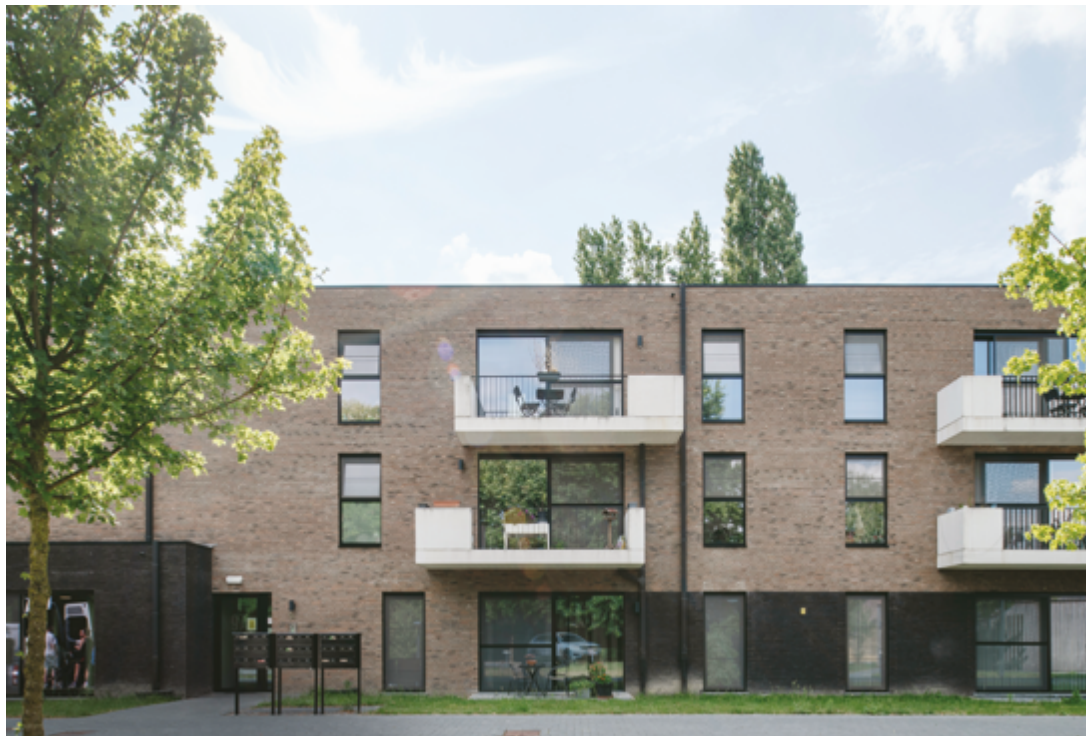
▲ Het gebouw bestaat uit twee delen: zestien wooneenheden voor het DIO-gedeelte ('diensten voor inclusieve ondersteuning') en elf aanleunwoningen.
