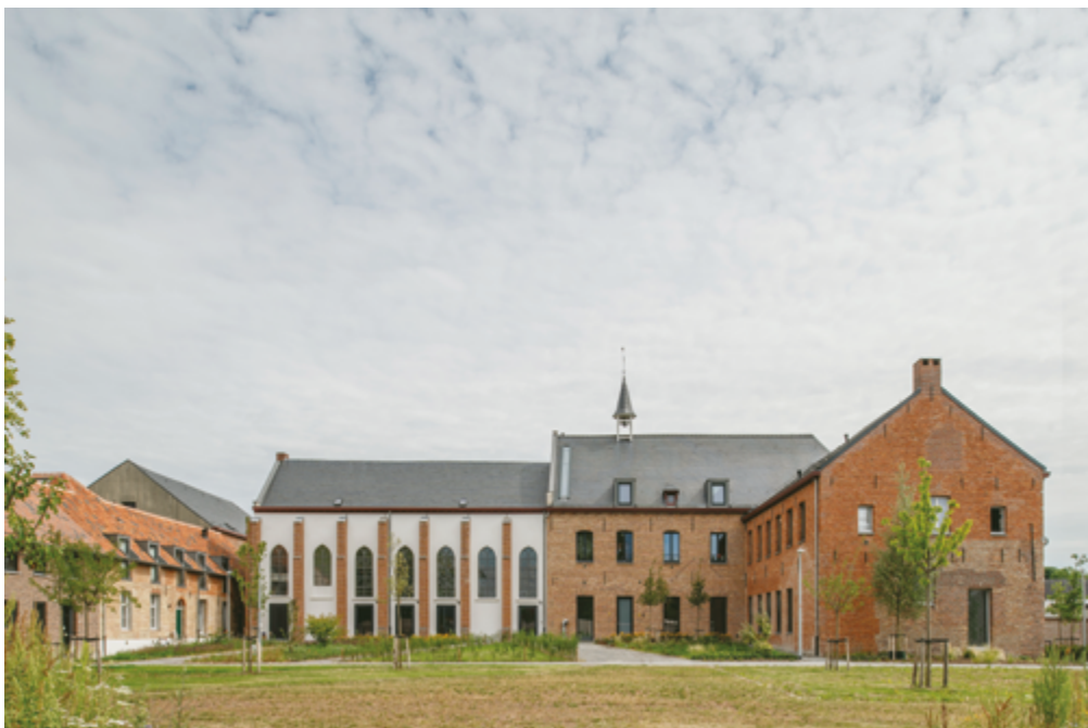
▲ De woningen zijn gescheiden van de gemeenschappelijke ruimtes, maar bewoners moeten via de kloostertuin naar de gemeenschappelijke schuur. De kapel wordt gebruikt voor buurtactiviteiten.
