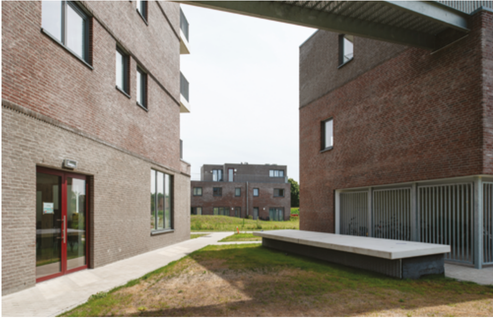
▲ Het project omvat 25 bijna-energie neutrale woningen voor alleenstaanden en gezinnen.
