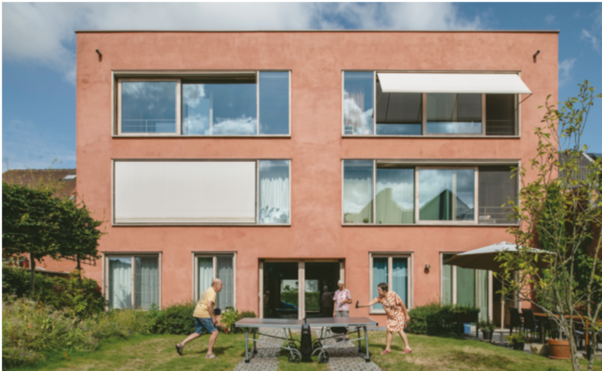
▲ Het project is gebouwd als duurzame massiefbouw met 40 cm dikke muren in massief metselwerk en bepleisterd met hydraulische kalk.
