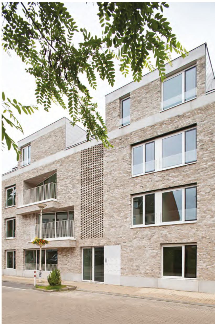
▲ Meergezinswoning in de Paalstraat in Schoten ontworpen door atelier MA+P. © Jolien Fagard
