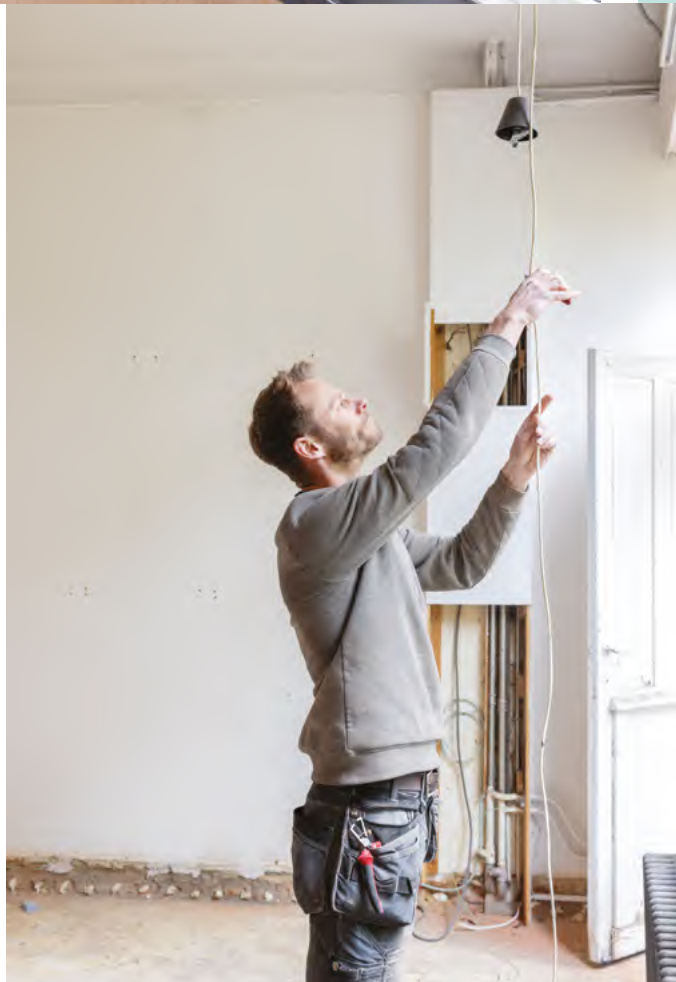
▲► Het Pandschap renoveert verwaarloosde panden tot kwalitatieve sociale huurwoningen. © provincie Antwerpen
