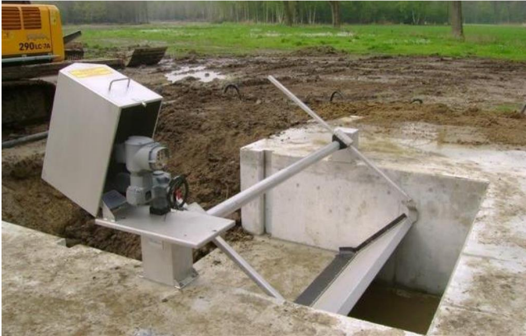
Klepstuw, bediening met stangen.
