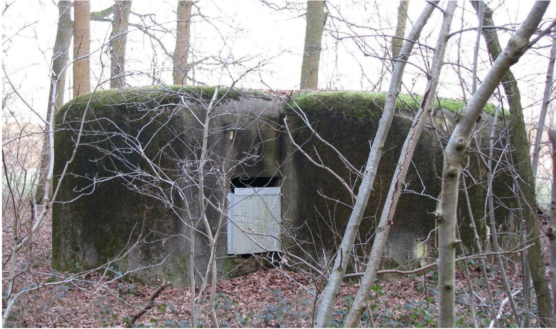
Een voormalige ijskelder die dienst doet als overwinteringsplaats voor vleermuizen © Mieke Hoogewijs – Provincie Antwerpen
