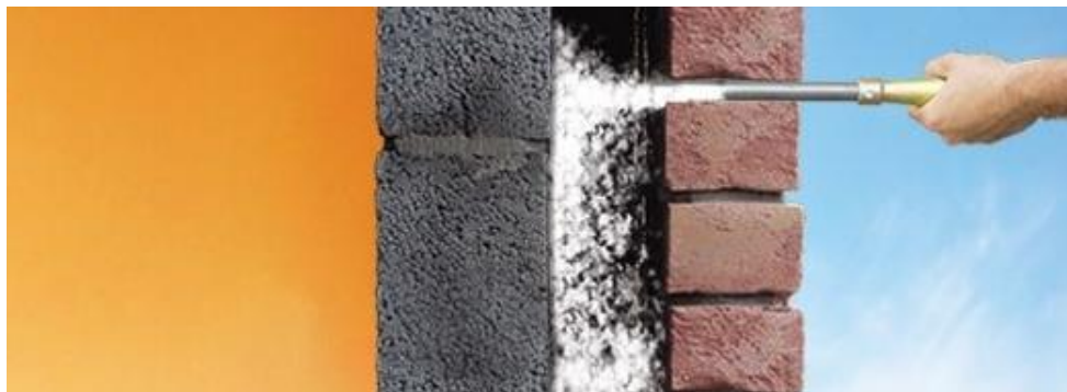
Isolatie wordt in de spouw gespoten om te isoleren
