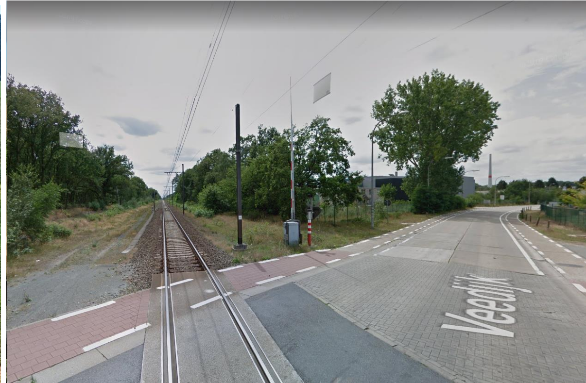
Kruispunt Veerdijk – spooroverweg: aanleg fietspad achter bedrijven langs Bleukenlaan
