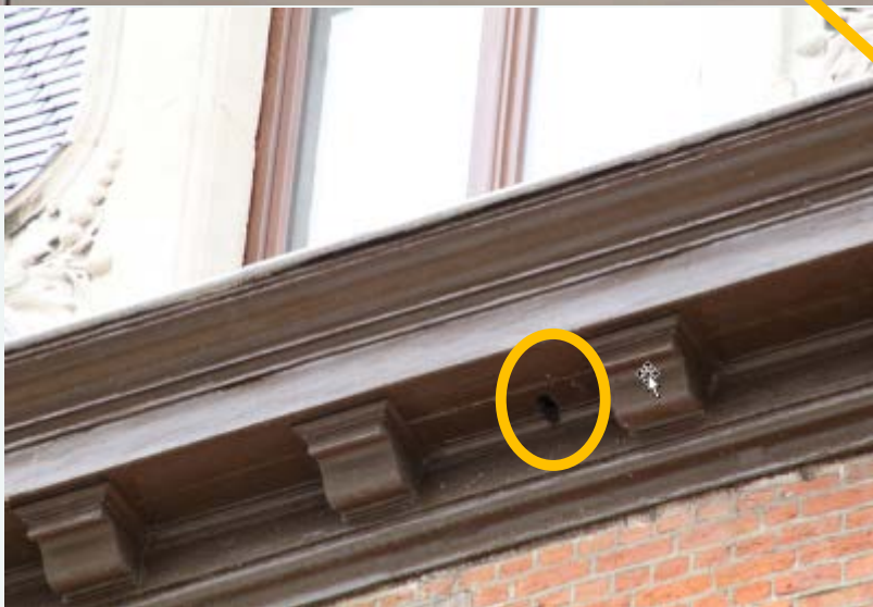
Dakgoot na renovatie 2018
