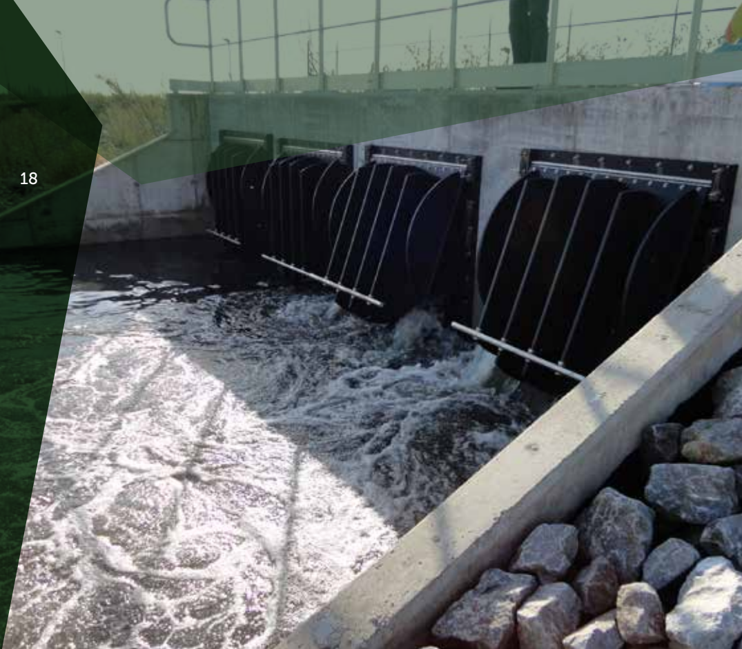
Vergelijkbaar pompstation aan de Bruchtse Weel
