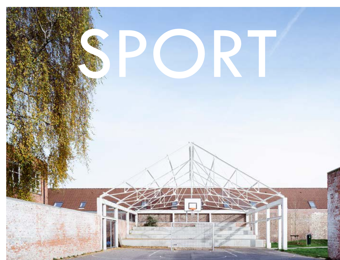
Wijkpark De Porre - Gent - Vandriessche Architecten
