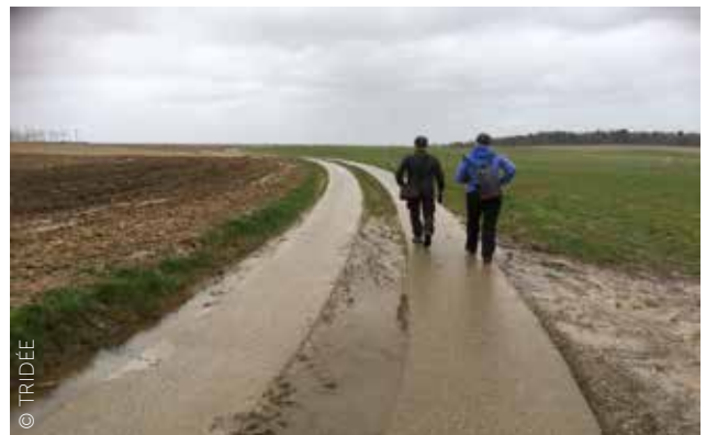
Links: Zwijndrecht. Smalle rijloper van asfalt en stevige onverharde randen. De weg straalt duidelijk uit dat hij niet is bedoeld voor doorgaand gemotoriseerd verkeer. Fietsers kunnen veilig uitwijken. Voor gemotoriseerd verkeer zijn er uitwijkmogelijkheden bij zijwegen of toegangen tot percelen. Rechts: Huldenberg. Door de betonnen sporen kunnen fietsers en voetgangers relatief comfortabel gebruik maken van de onverharde landbouwweg. Dit profiel is niet geschikt voor intensief gebruik door autoverkeer of fietsers.
