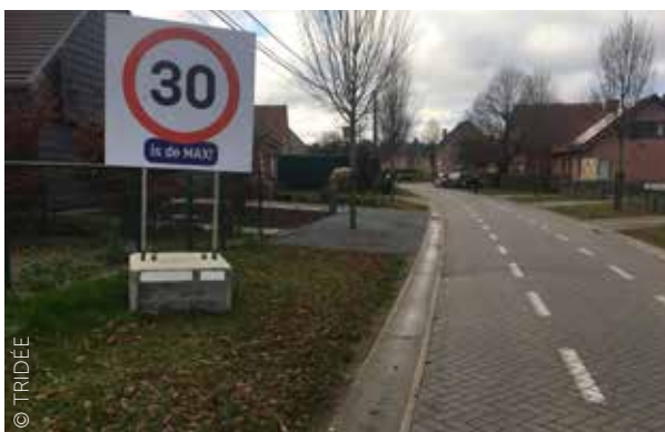
Lille. Duidelijke communicatie over de maximumsnelheid. Het profiel met een midden rijbaan is sinds september 2022 opgenomen in de wegcode. Automobilisten rijden in principe in het midden en wijken uit naar de kant om een tegenligger te passeren. Dit profiel werkt vooral goed bij weinig gemotoriseerd verkeer.
