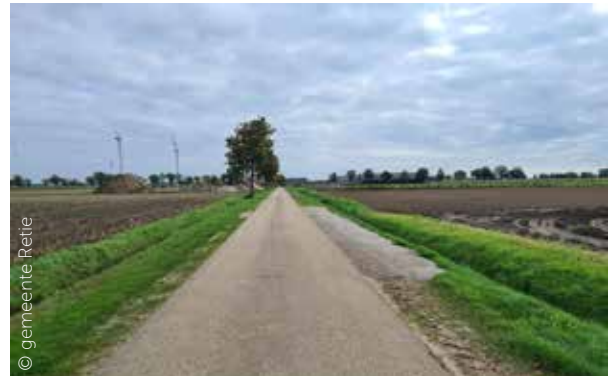
Retie. Passeerplaats door halfverharding van de berm.
