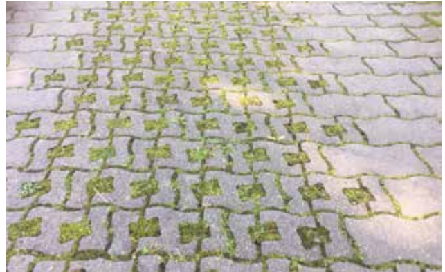
Thüringen. Voorbeeld van goed befietsbare grasdals in het midden. Ze versterken het landelijke effect. De twee goed befietsbare stroken zijn uitgevoerd met een ander soort elementenverharding.
