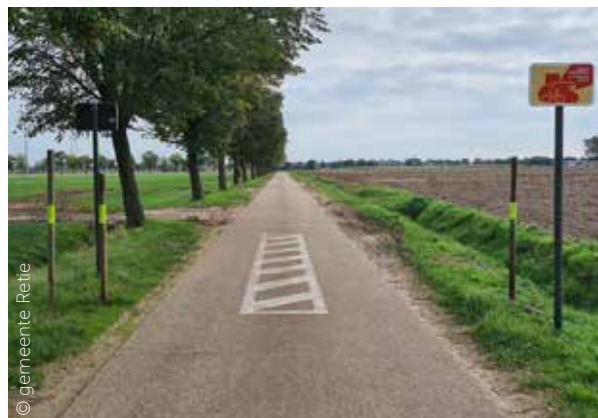
In Retie werd een poorteffect gesimuleerd via een proefopstelling: verandering van wegdek door grasdals op de locatie van de gearceerde markering, versmalling van het wegdek door objecten langs de weg en sensibilisering door het bord Gedeelde Landbouwwegen.
