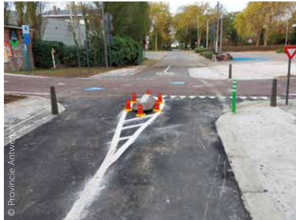
Recent aangelegde tractorsluis. Het obstakel is duidelijk herkenbaar door belijning en reflectoren.
