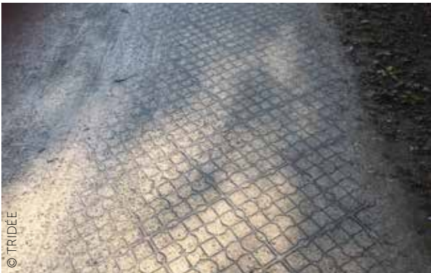
Links: Voorbeeld van een versteviging van de berm met matten. Rechts: Voorbeeld van een rijloper voor fietsers en grasdals aan beide kanten.
