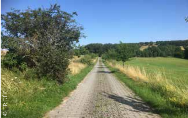
Thüringen. Voorbeeld van goed befietsbare grasdals in het midden. Ze versterken het landelijke effect. De twee goed befietsbare stroken zijn uitgevoerd met een ander soort elementenverharding.
