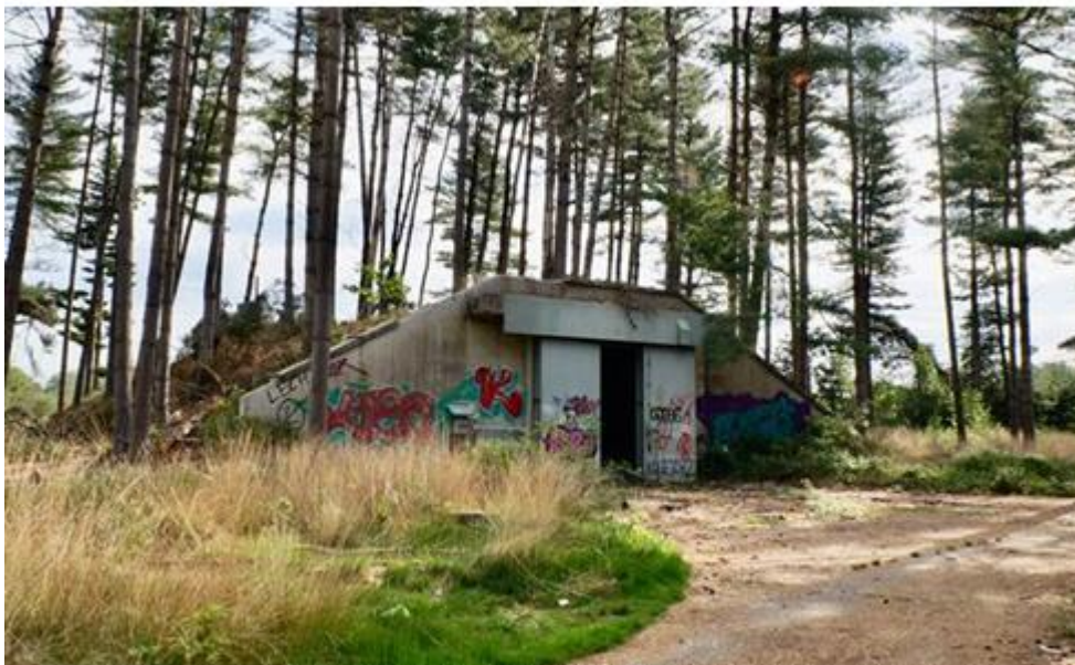
Foto van één van de bunkers op het militaire domein in Arendonk - Copyright: Provincie Antwerpen
