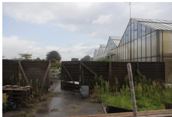
FOTO 6: toegang naar zone buitenverkoop vanuit de zone voor buitenopslag (niet publiek toegankelijk)
