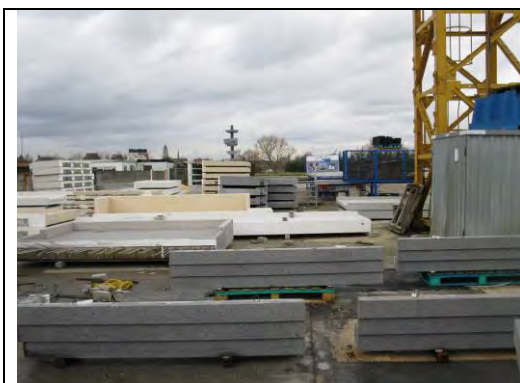
Foto 7: opslag voor torenkraan
