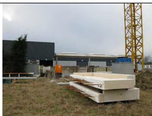
Foto 12: vanaf opslag richting kleine bedrijfshal
