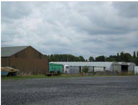
Zicht op de gebouwen (magazijn en productie) langs de achterzijde (woonstraat)
